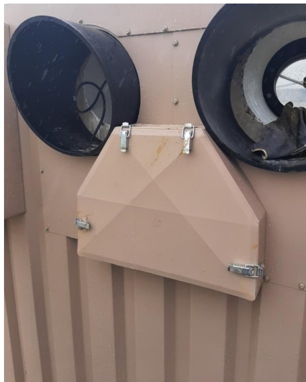
Рисунок 25. Защита от атмосферных воздействий трубопровода воды
