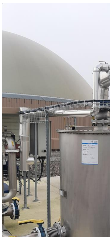
Рисунок 22. Защита от замерзания трубопровода анализируемого газа
