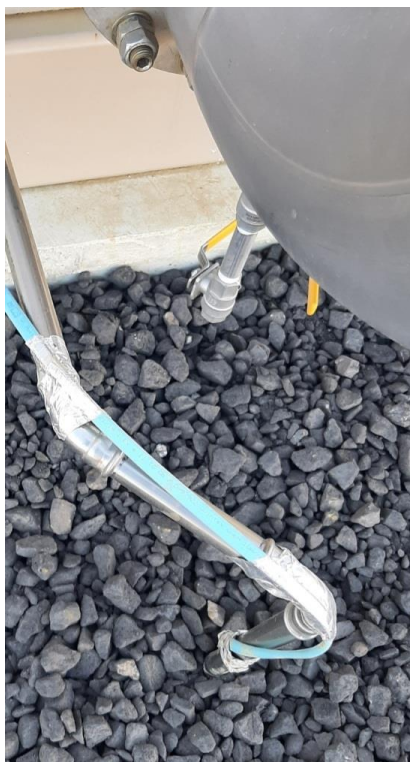
Рисунок 13. Сопровождающий обогрев трубопровода конденсата
