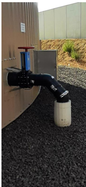
Рисунок 11. Сопровождающий обогрев трубопровода отбора
