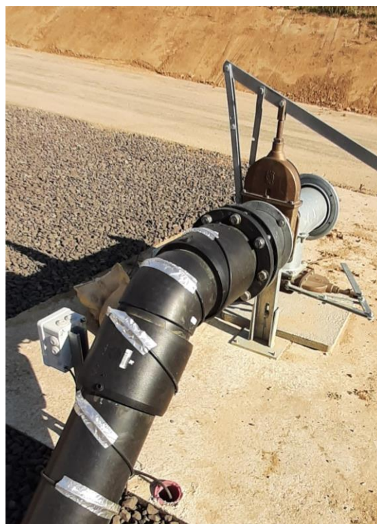
Рисунок 12. Сопровождающий обогрев станции отбора
