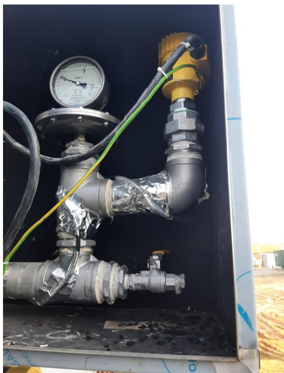
Рисунок 15. Сопровождающий обогрев датчиков и защита от атмосферных воздействий
