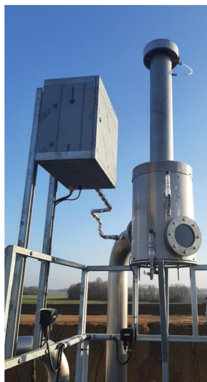
Рисунок 23. Защита от замерзания датчиков и защита от избыточного давления
