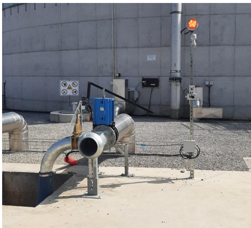
Рисунок 19. Защита от замерзания станции отбора
