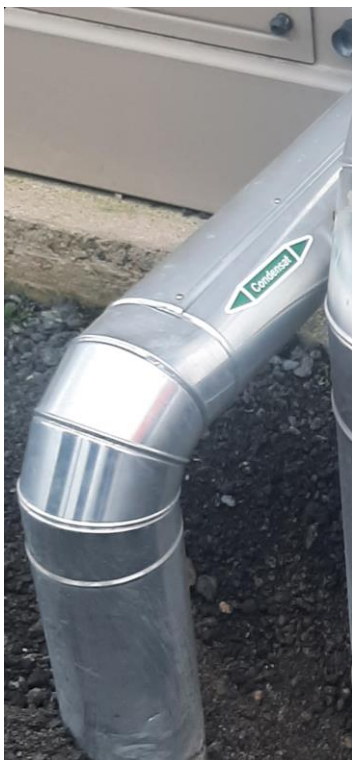
Рисунок 24. Защита от атмосферных воздействий и теплоизоляция трубопровода конденсата
